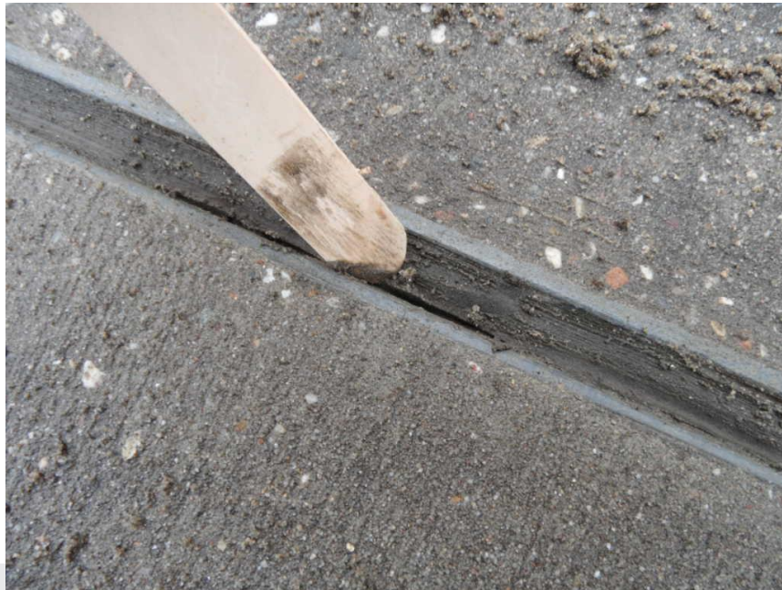
Foto: Afdichting is onthecht.
