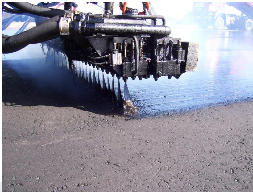
Foto: Aanleg vloeistofdichte asfaltconstructie.
