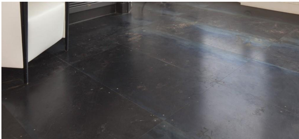
Foto: Voorziening van aan elkaar gelaste metaalplaten.
