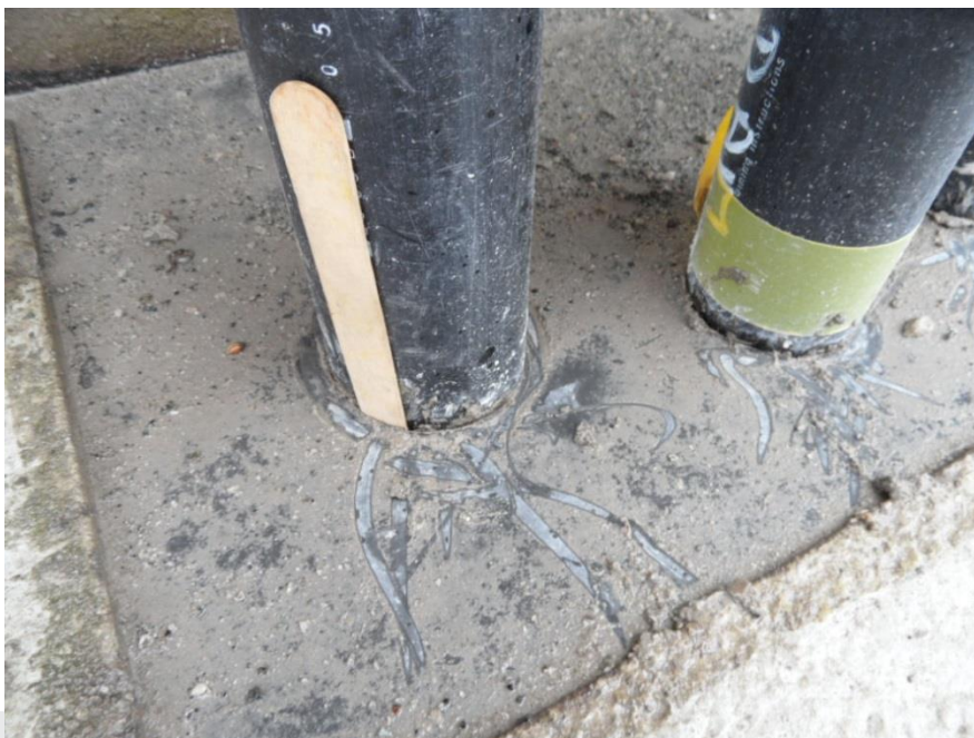
Foto: Voorbeeld van een niet-afgedichte doorvoer.
