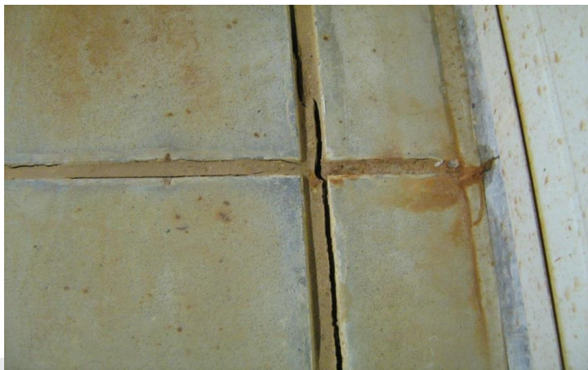
Foto: Beschadigde kitvoeg.
