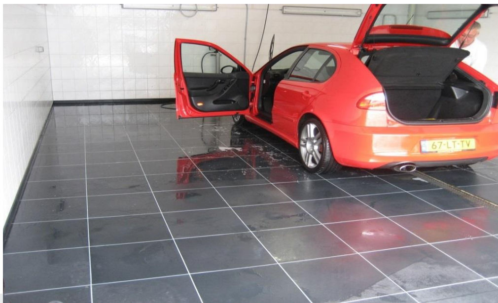
Foto: Vloer uitgevoerd met kunststof elementen.
